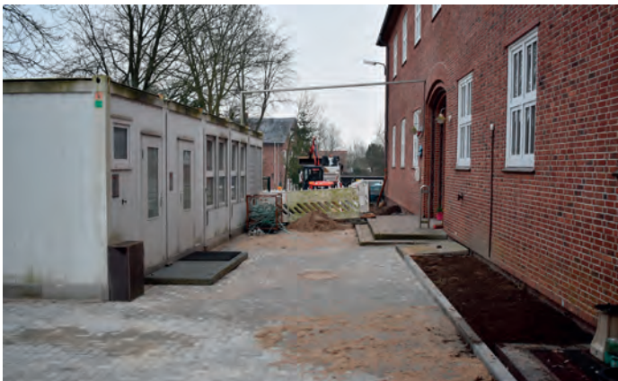
Während der Sanierung kann es zu einigen Einschränkungen kommen. Bilder: Constabel
